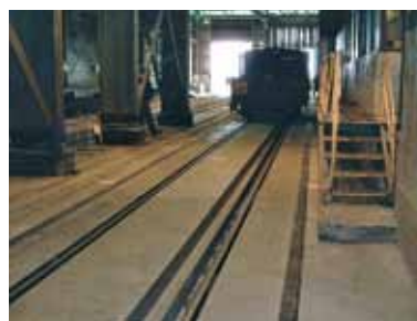
Cubierta de Acero
