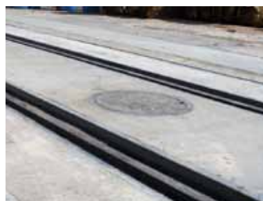
Cubierta de Concreto
