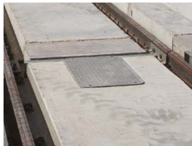
Plataforma de hormigón
